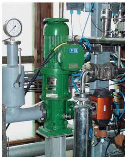
Typ SMV ze sprzęgłem magnetycznym. Ciecz: ścieki chemiczne.
