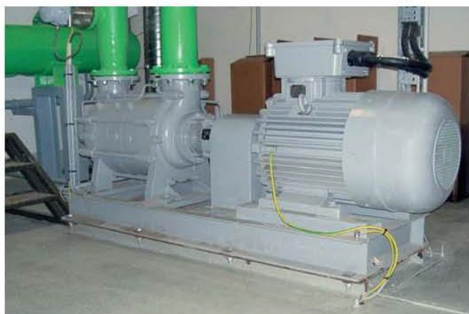
Typ HZS z pojedynczym uszczelnieniem mechanicznym. Ciecz: benzyna, diesel 20°C.
