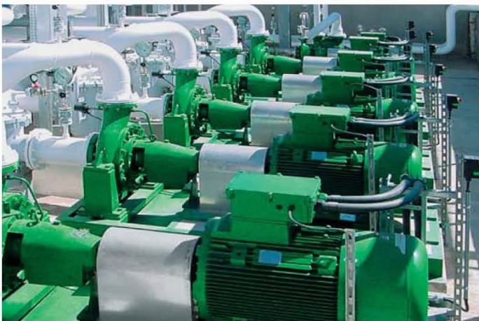
Typ NCR wg API 610 wyd.7 z pojedynczym mechanicznym uszczelnieniem. Ciecz: paliwo lotnicze JP4.
