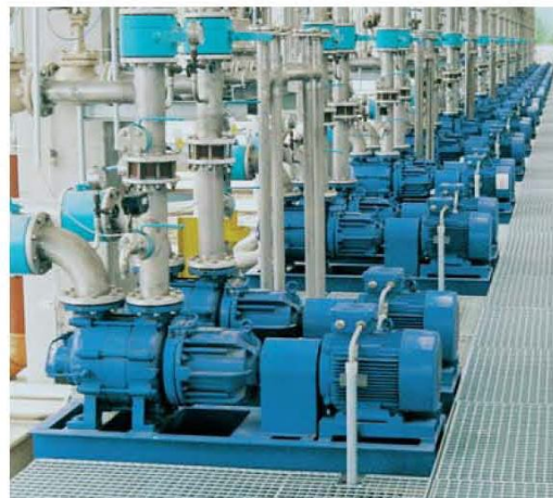
Typ HZSM ze sprzęgłem magnetycznym. Ciecz: rozpuszczalnik, 20°C.
