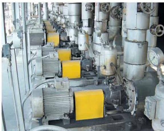
Typ NCL z podwójnym uszczelnieniem mechanicznym mieszkowym (N9). Ciecz: olej, 330°C.
