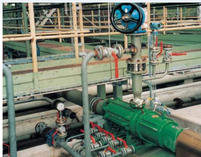
Typ HZMR ze sprzęgłem magnetycznym. Ciecz: mieszaniny benzenu.
