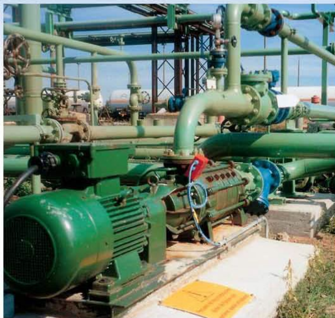
Typ HZSMA ze sprzęgłem magnetycznym. Ciecz: propan/butan, 20°C.
