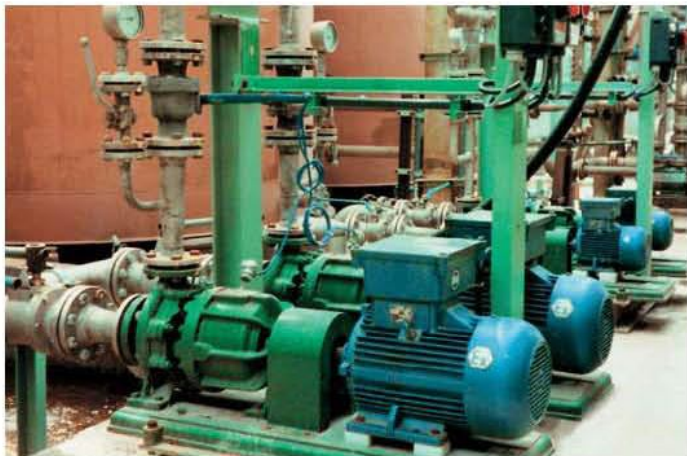
Typ NML ze sprzęgłem magnetycznym. Ciecz: chlorek metylenu, 40°C.
